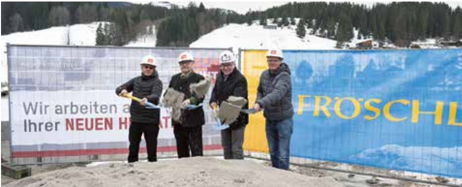
Im Dezember 2024 erfolgte für das Bauvorhaben „Urschner III“ der offizielle Spatenstich.
