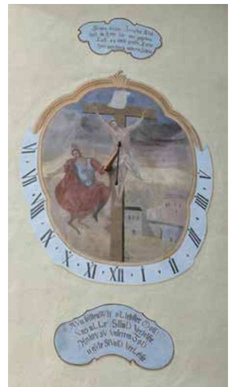
Die restaurierte Sonnenuhr von 1762 auf der Südseite der Pfarrkirche Achenkirch.
